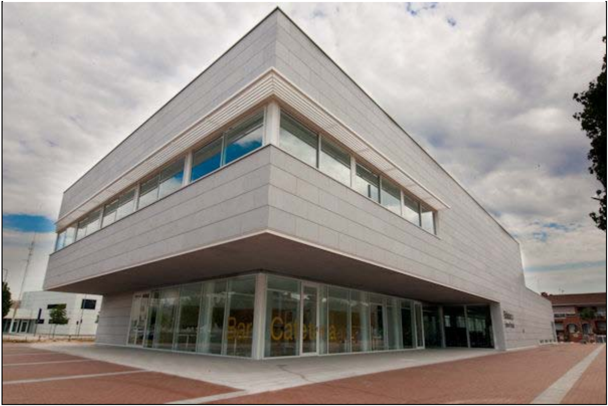
Figura 12. Façana d'accés a la biblioteca
