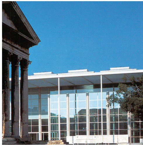
03.07 Mediateca de Nimes, França. Arquitecte: Norman Foster, 1984.
