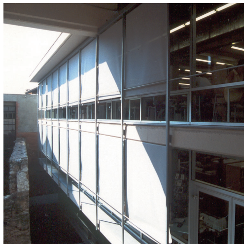
11.03 Biblioteca Can Pedrals. (Granollers, Barcelona). Arquitectes: Riera, Gutiérrez i Associats.
