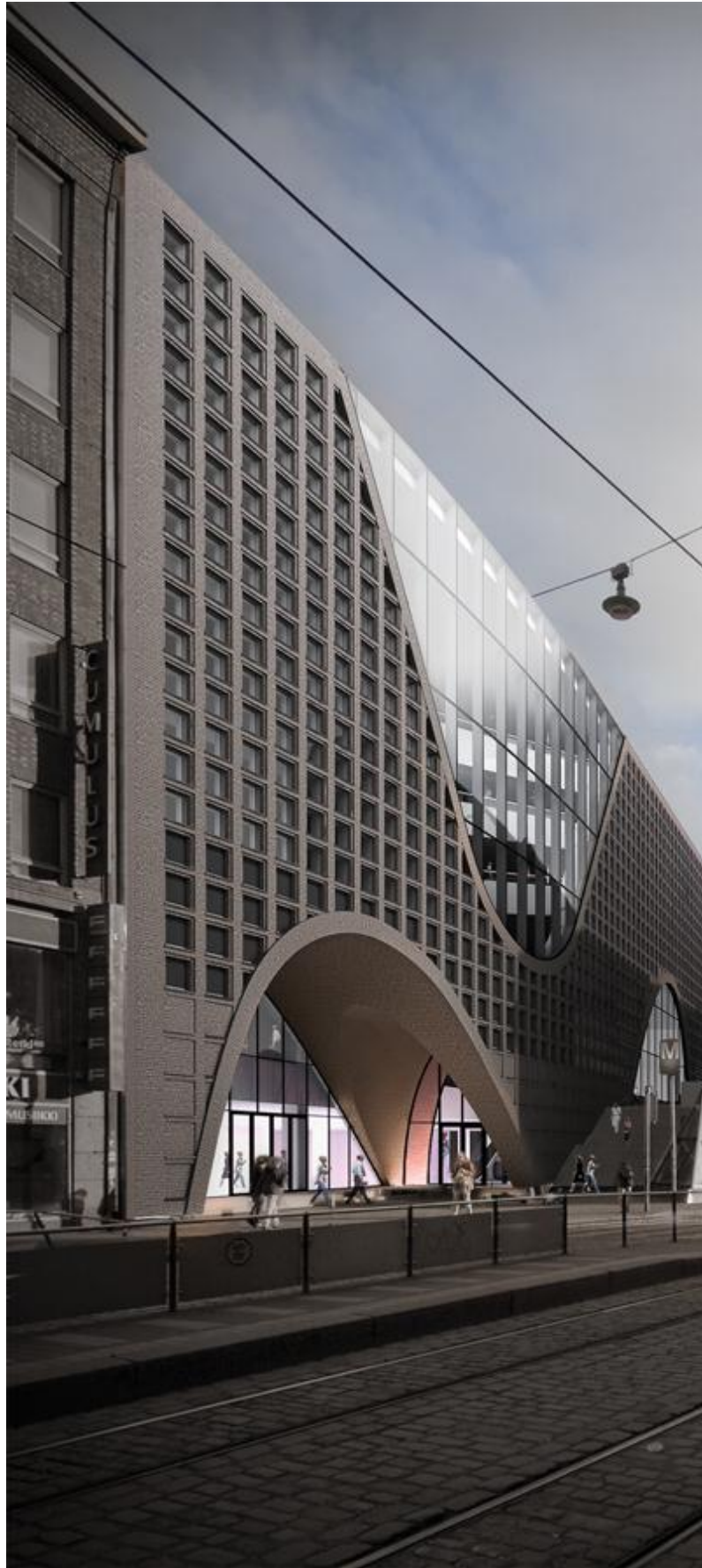
Foto 2: La Biblioteca Central – Kaisaniemenkatu 5.
